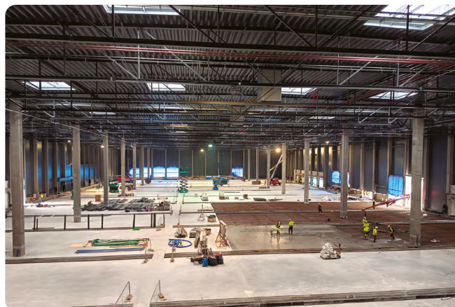
Sobre estas líneas, una de las entradas de la feria y nuevo pabellón en obras.
